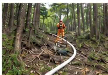
中継ポンプで 高所へ送水
